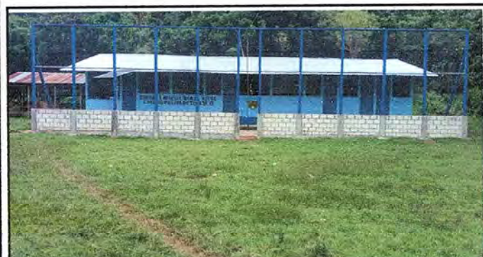
Foto 3. Parte frontal, el entechado ya no sufrirá daños con los juegos de futbol.
