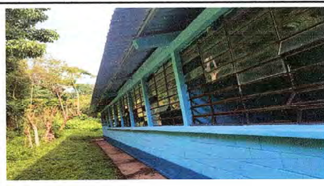
Foto 4: Vista desde la parte de atrás, entechado largo y pintura de la pared terminada.
